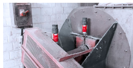
Lubricación de un cojinete de soplador
