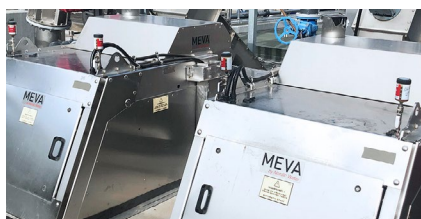
Lubrificação das engrenagens da peneira
