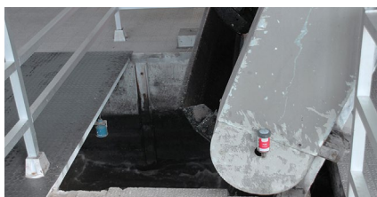
Lubrificação dos rolos-guia da correia
