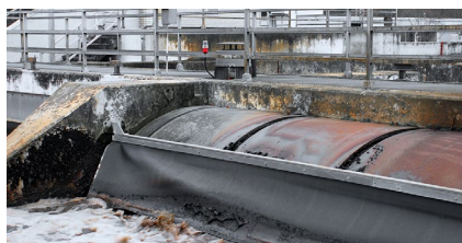
Lubrificação do rolamento na ventoinha do tanque aerado
